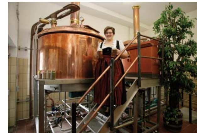
Blick in die Brauerei
